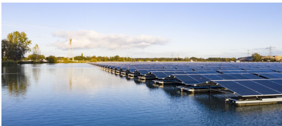
Afbeelding 3.6 Illustratie beoogd type drijvend zonnepark (Zim Float)
