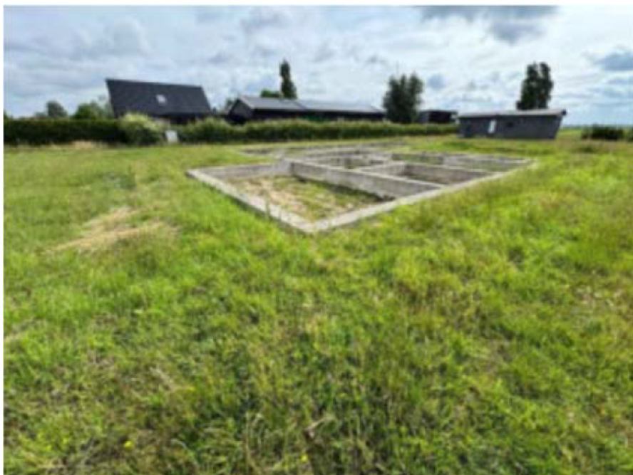
Fig. 1.1: aangelegde fundering woning voorjaar 2021
