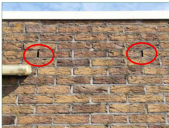
Openingen in spouwmuren (bakstenen gebouwen, links) en achter loszittende gevelbetimmering (houten gebouw, rechts) geven mogelijk toegang tot voor vleermuizen geschikte achterliggende ruimtes.
