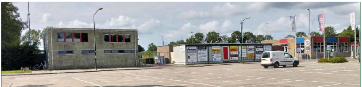
Foto genomen vanaf de parkeerplaats, de te slopen verenigingsgebouwen van links naar rechts: het hoge gebouw met houten behuizing, een noodgebouw/bouwkeet en twee bakstenen gebouwen die onderling verbonden zijn.
