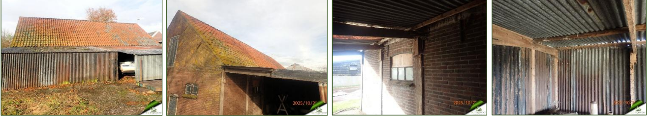
Figuur 9. Van stalen golfplaat aangebouwde bergruimte tegen gevel van opstal 3
