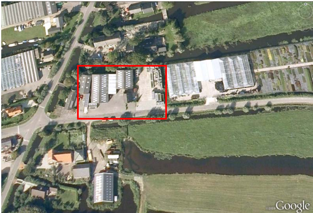
Figuur 6: huidige bebouwing op de projectlocatie
