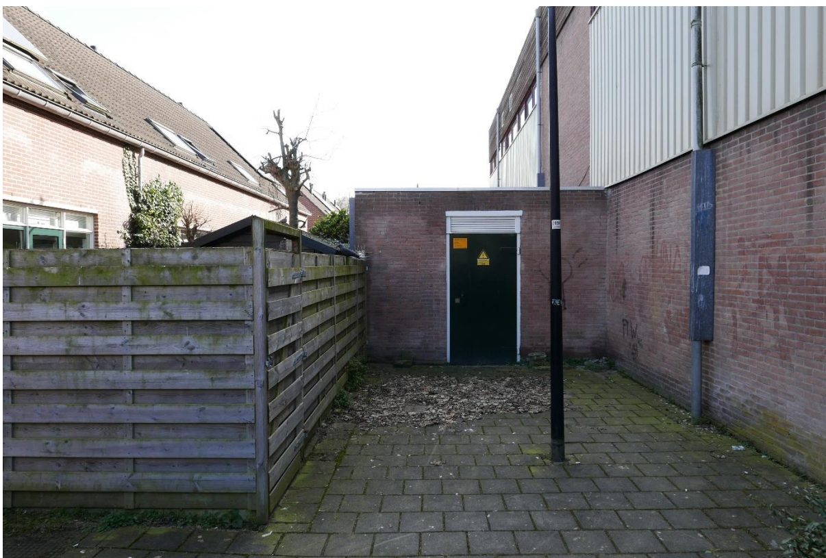
Te handhaven trafokast
