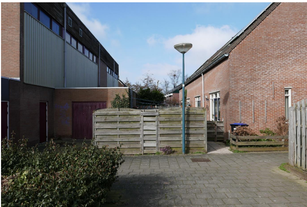
Inrit naar garage op eigen terrein op de hoek van de Heinkuitenhof
