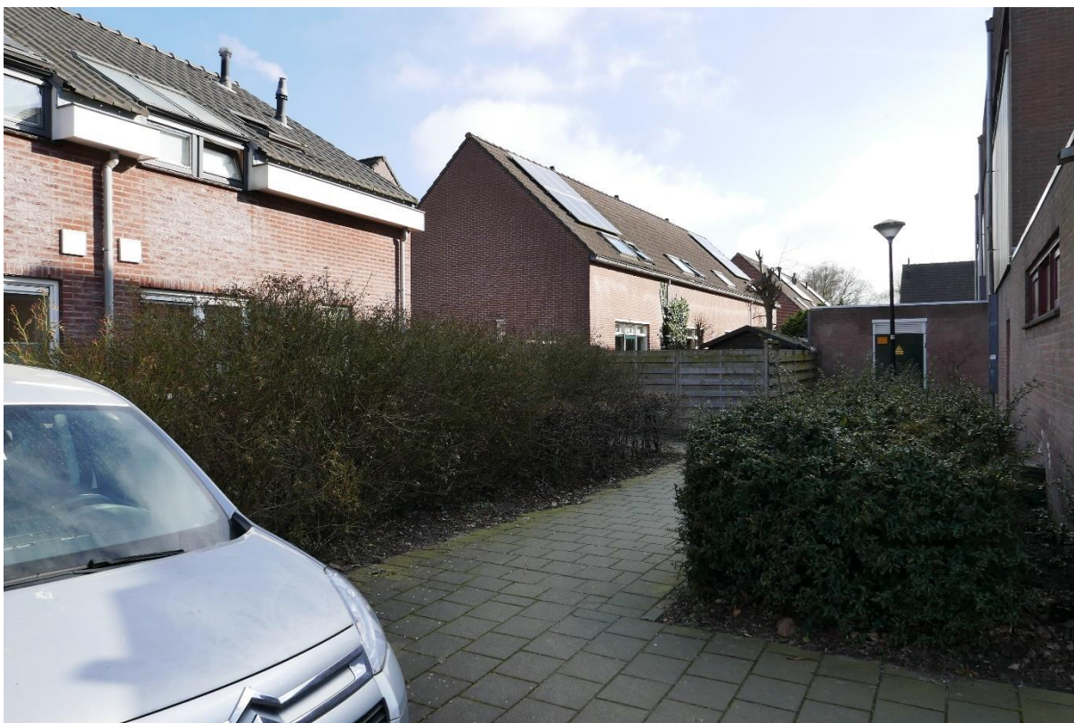
Holendrecht met insteekstraat naar transformatorhuis achter sportzaal
