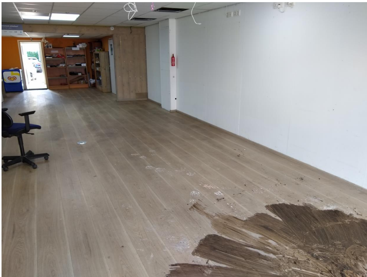
Figuur 3. Situatiefoto in Dorpsstraat 58 vanaf de ingang van het pand.
