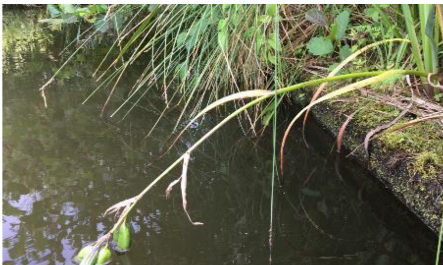
Detail beschoeiing locatie uitstroomvoorziening inlaat, juli 2020
