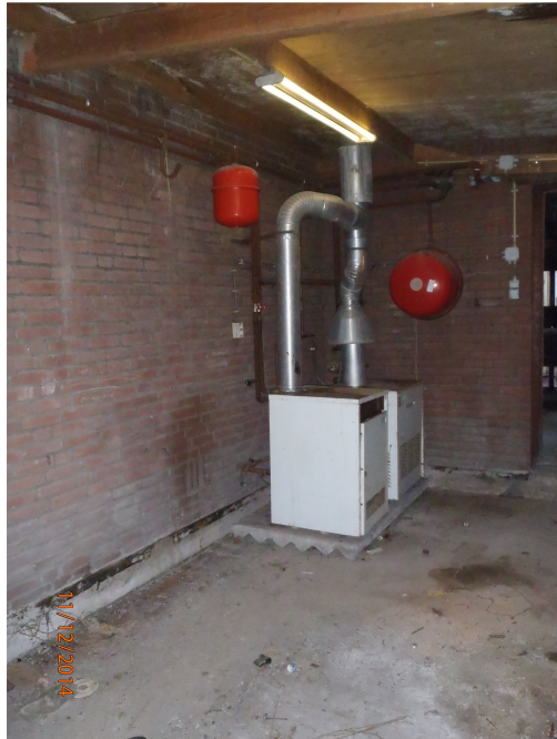
Afbeelding 9 & 10. De binnenzijde (links) van de C.V.- ruimte en de zolder (rechts)
