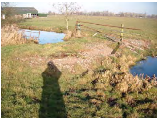
20. Dam met gebroken puin
