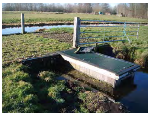
22. dam met gebroken puin
