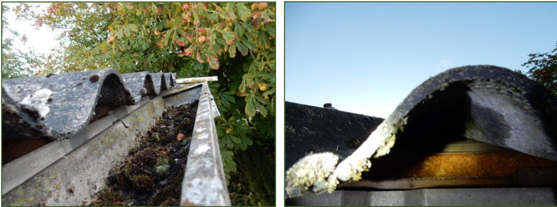
Foto's: Nadere inspectie dak.
