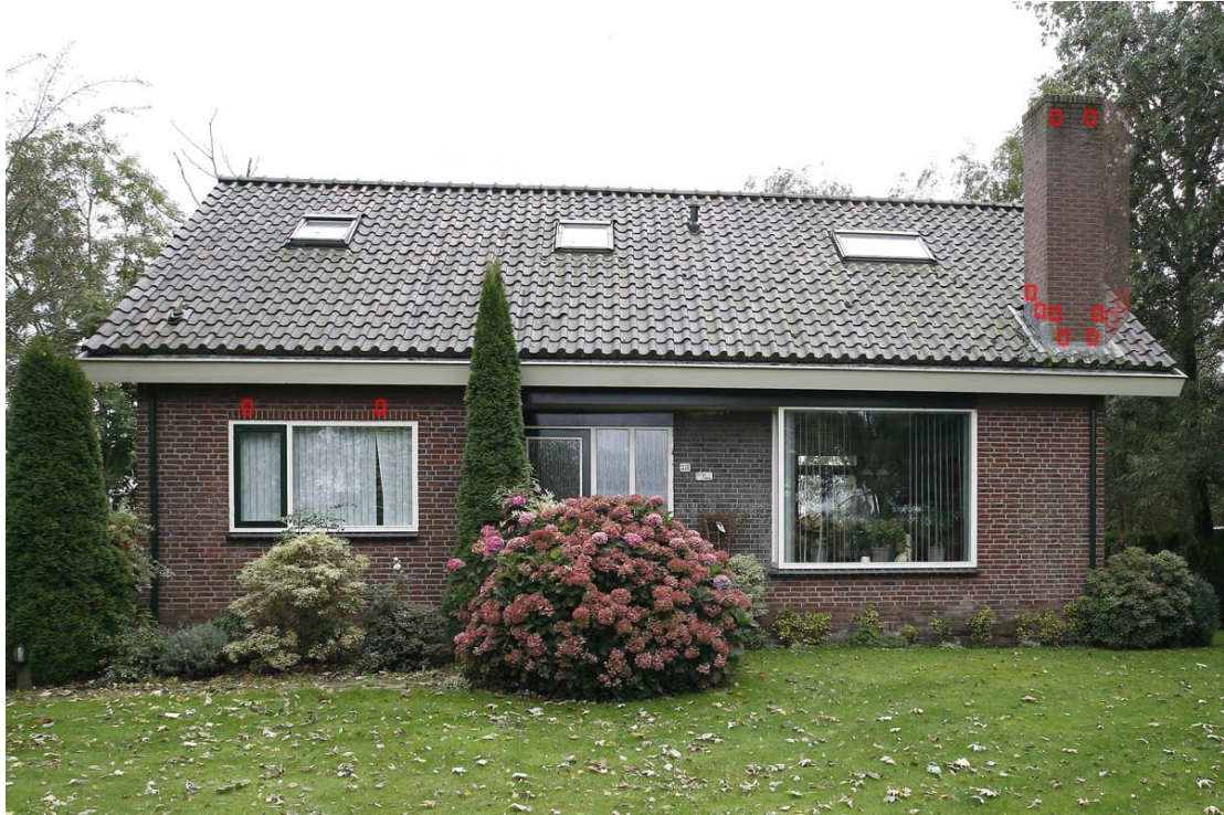
afb.1: locaties van spouwvoegen aan de voorzijde van het huis.
