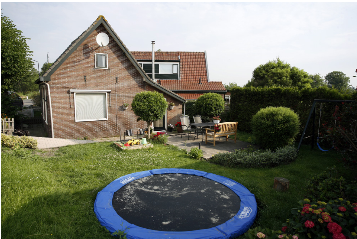
Afb.4: Het te slopen huis en in de voorgrond de tuin waarop de nieuwbouw komt.
