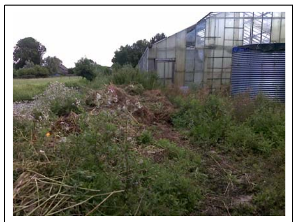
Foto 12: Buiten achterzijde stookhok
