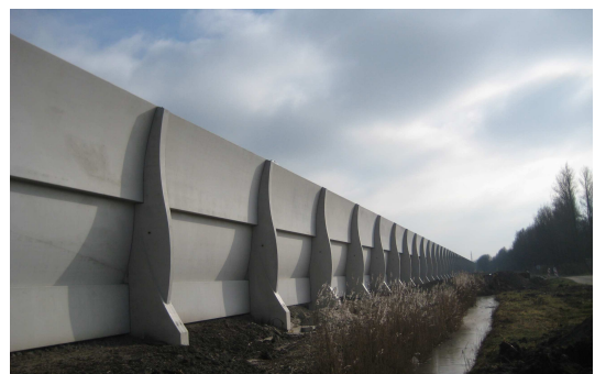
Geluidschermen in aanbouw achterkant, richting Utrecht
