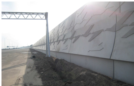
Geluidschermen in aanbouw wegkant, richting Utrecht
