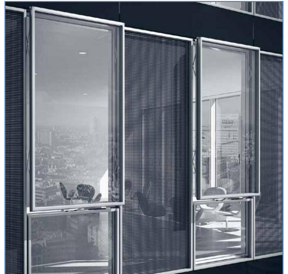
Figuur 11: voorbeeld van parallel uitzetramen.
