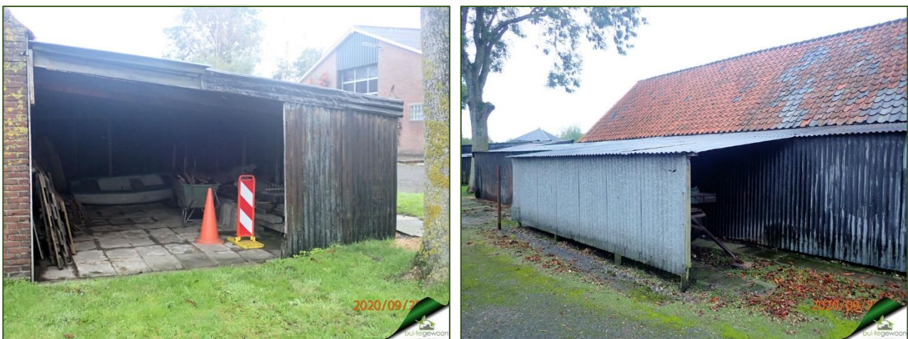
Figuur 12. Opstal 4 oostzijde. Van stalen golfplaat aangebouwde bergruimte tegen te handhaven schuur
