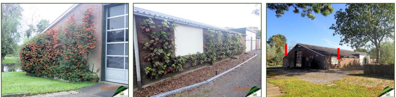
Figuur 10a. Beplanting tegen opstal 3 in 2020
