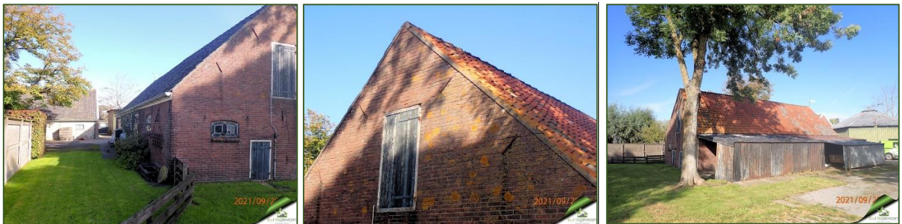
Figuur 11. Westelijk deel opstal 4
