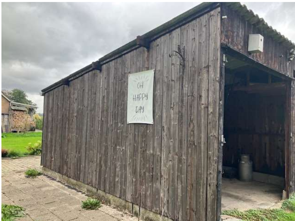
• Afbeelding 4: Houten garage
