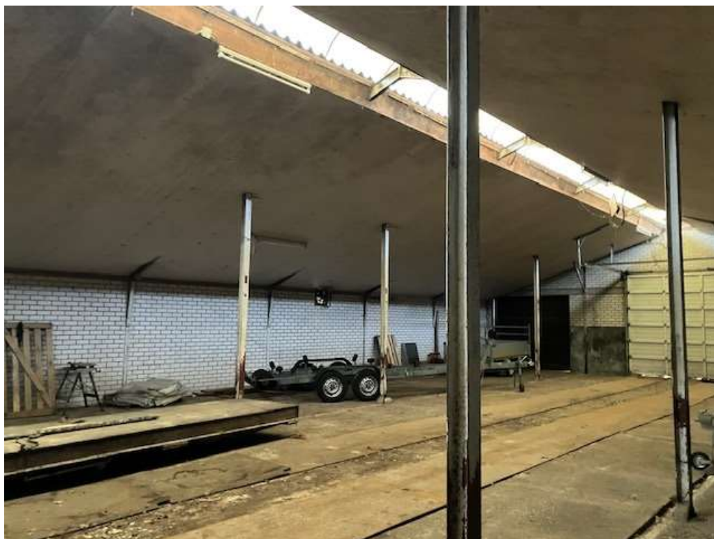
• Afbeelding 17: Binnenzijde voormalige koeienstal, dak aan onderzijde geïsoleerd
