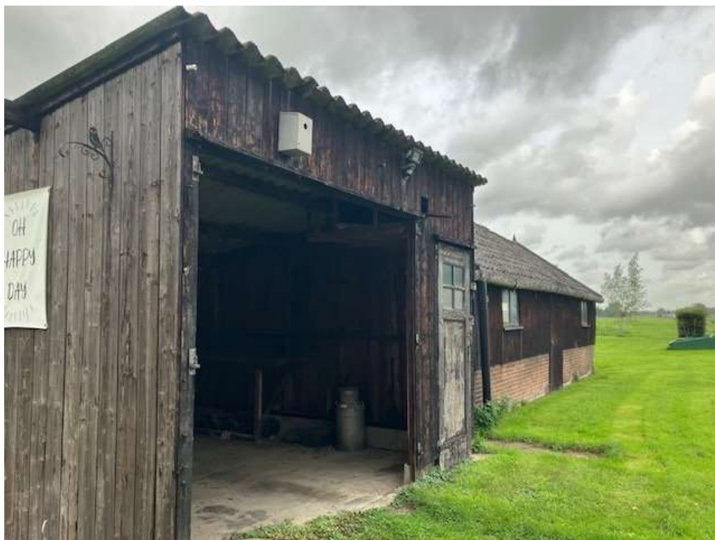
• Afbeelding 5: Houten garage
