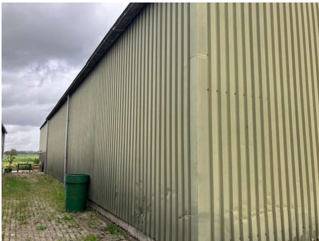
• Afbeelding 11: Buitenzijde tweede damwand schuur, met bestrating rondom
