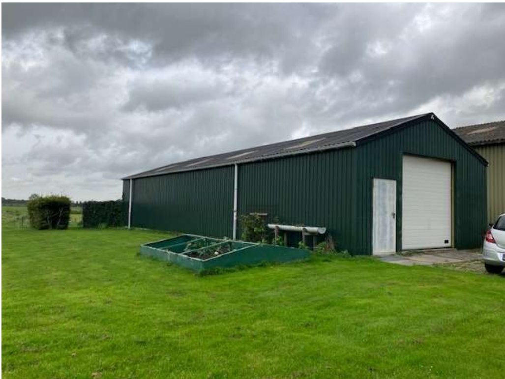
• Afbeelding 8: Te slopen schuur met damwand gevelbeplating en golfplaten dak
