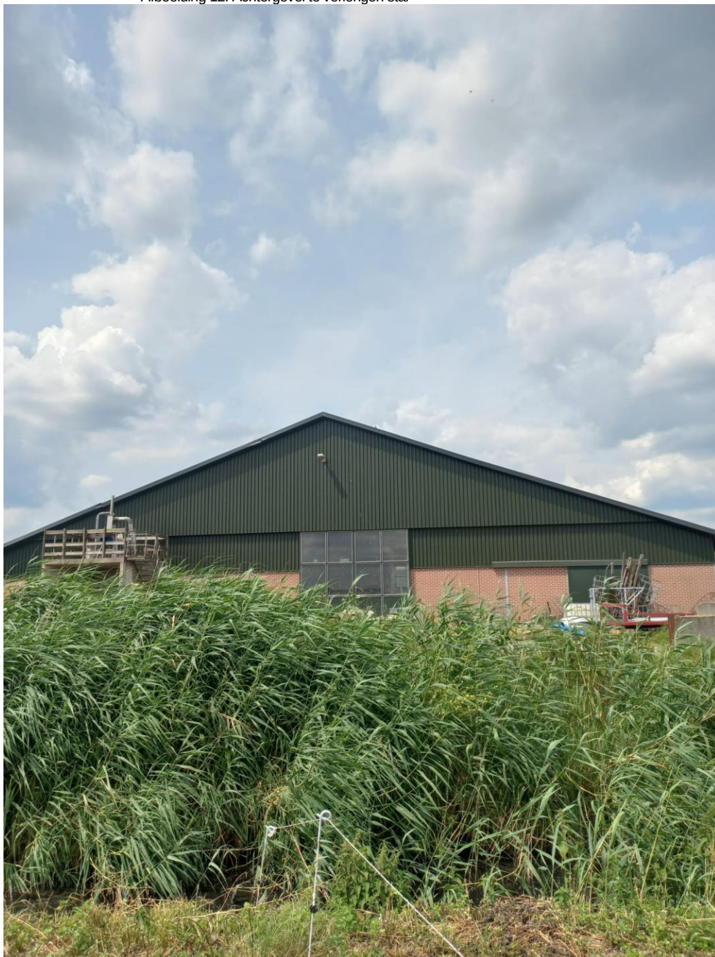
• Afbeelding 12: Achtergevel te verlengen stal
