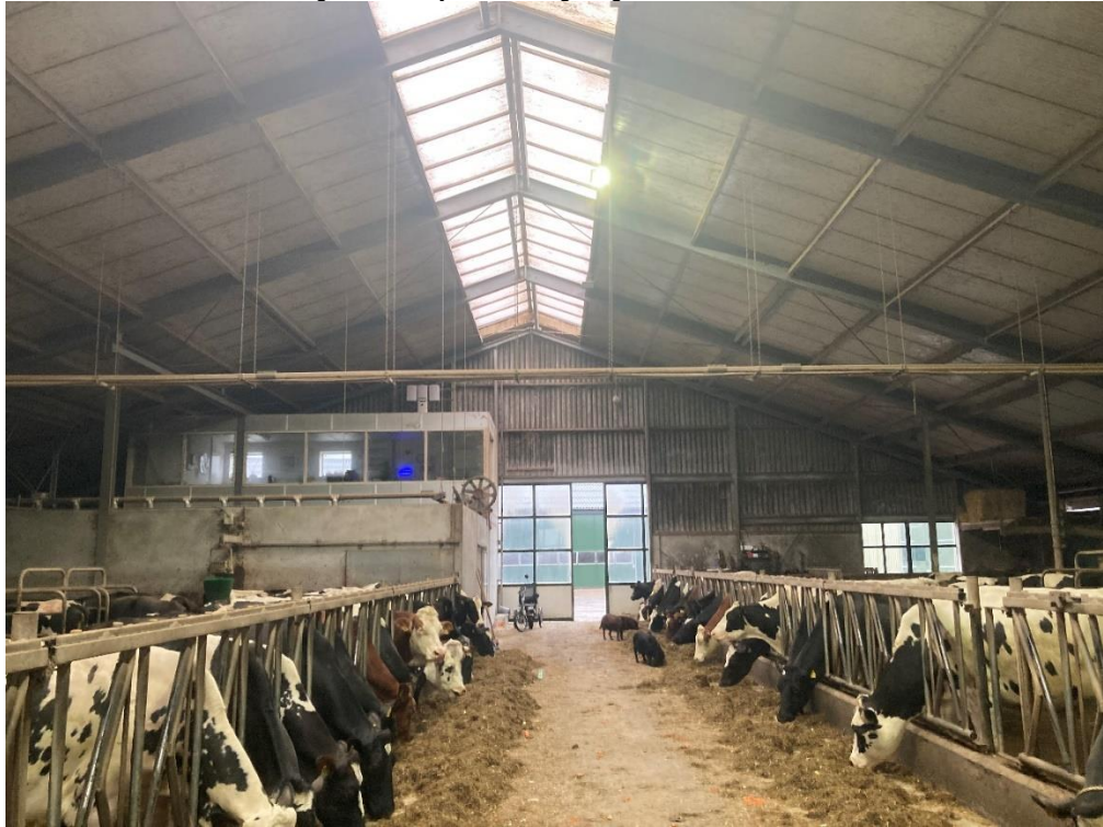
• Afbeelding 5: Binnenzijde te verlengen ligboxenstal
