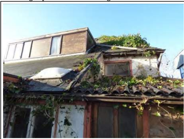
Foto 5: golfplaten dakbedekking
