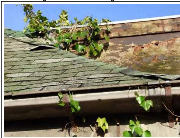
Foto 6: shingles als dakbedekking
