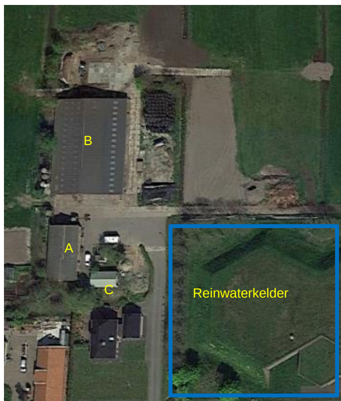
Figuur 2-2 Luchtfoto huidige situatie
