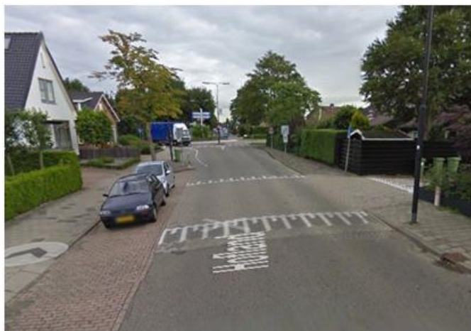
Afbeelding 4 De Hofland ter hoogte van de Wijde Blick
