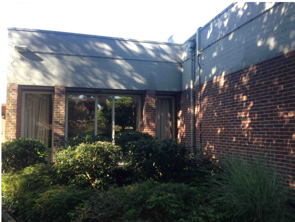
Figuur 3 Het kantoorgebouw bestaat uit gemetselde muren met deels een betonnen afwerking, het dak bestaat uit een laag bitumen.
