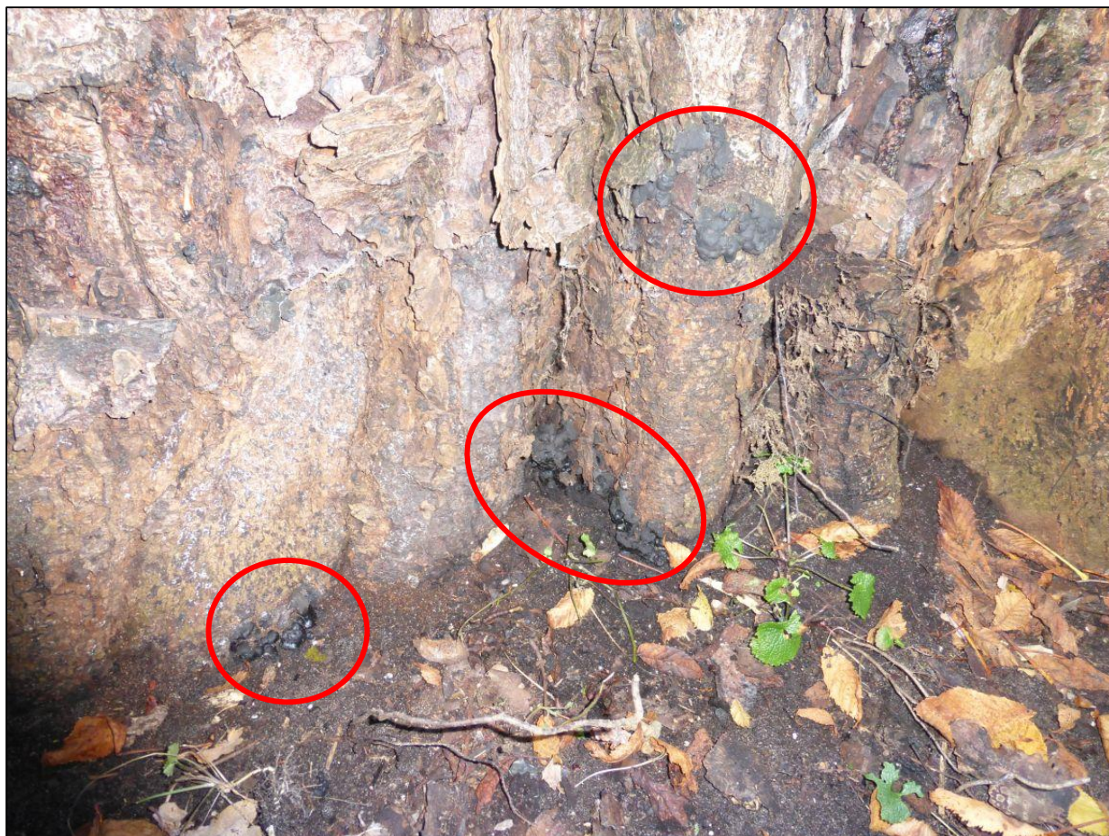
Foto 6: boom nummer 9, korsthoutskoolzwam op noordzijde stamvoet (rood). Stamvoet is deels gerot over een breedte van 60 cm ter hoogte van het maaiveld.
