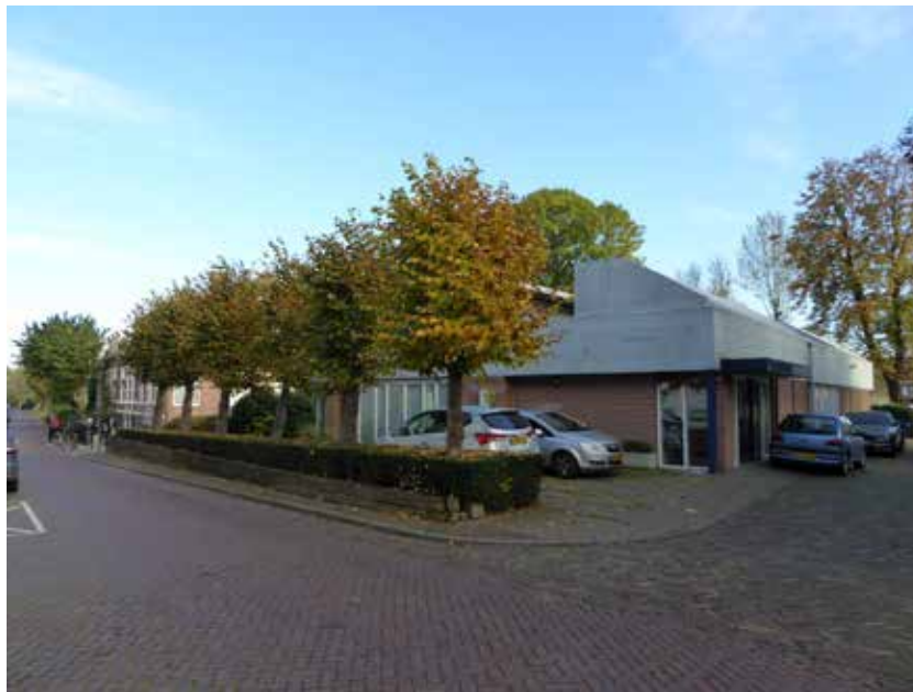
Voorzijde van het voormalige Rabobankgebouw met leilindes
