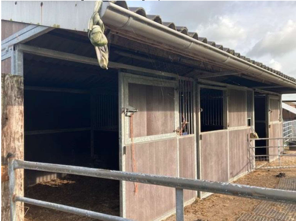
• Afbeelding 20: Paardenstal wordt gesloopt
