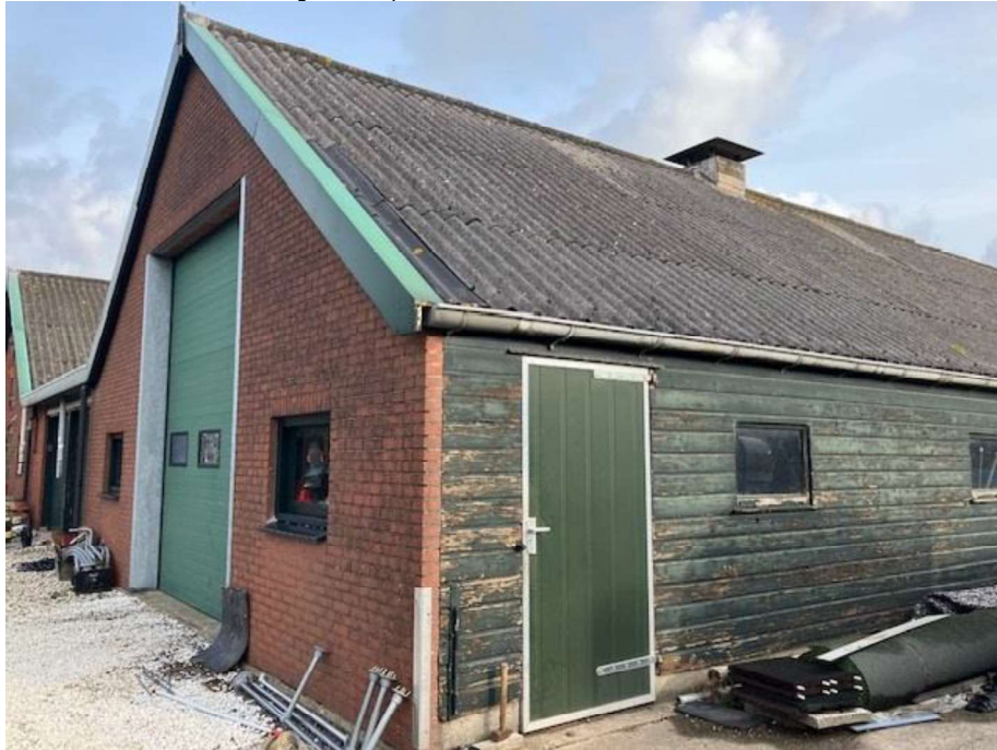
• Afbeelding 4: Te slopen schuur
