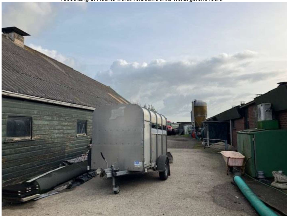
• Afbeelding 5: Rechts wordt verbouwd links wordt gerenoveerd
