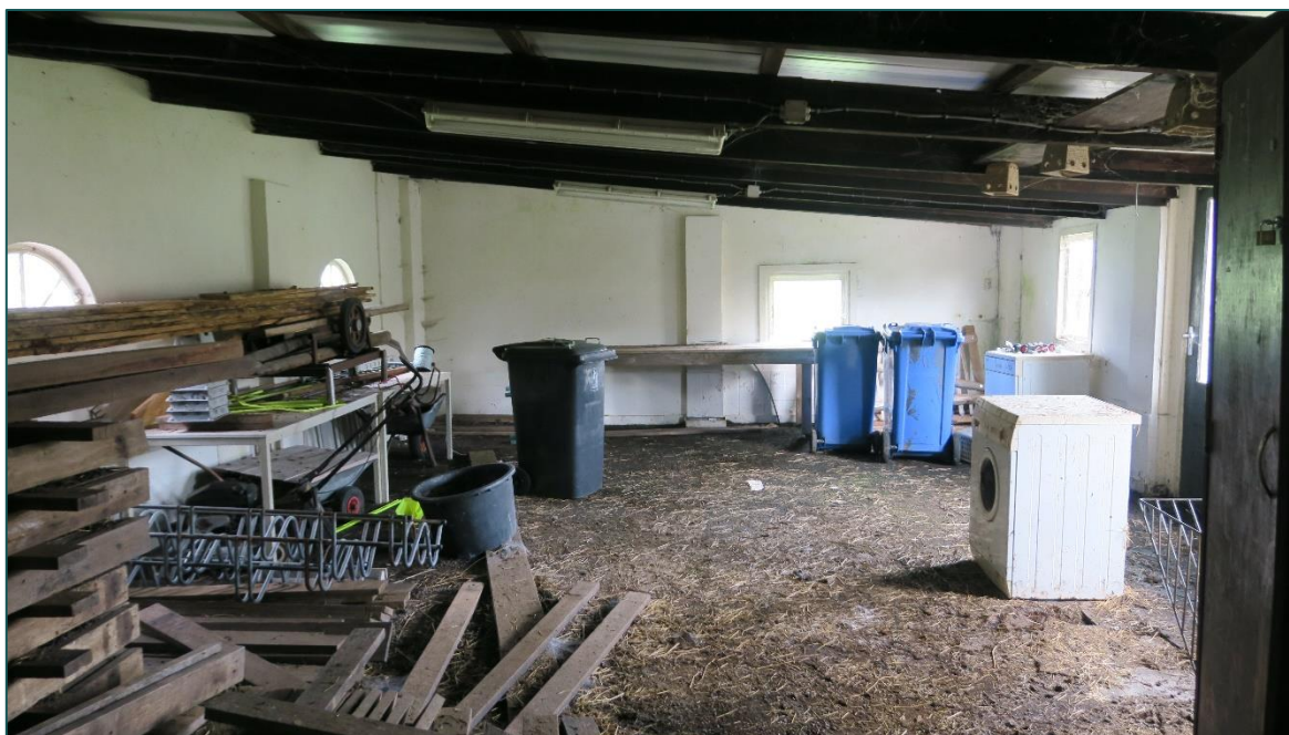
Figuur 4 De opslagruimte in de voormalige kantine, het dak heeft dakbeschot.
