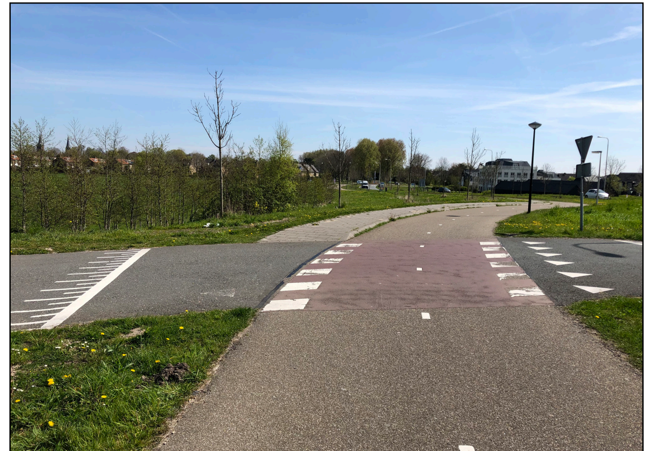
Fietspad vanuit bushalte/carpoolplaats richting Abcoude
