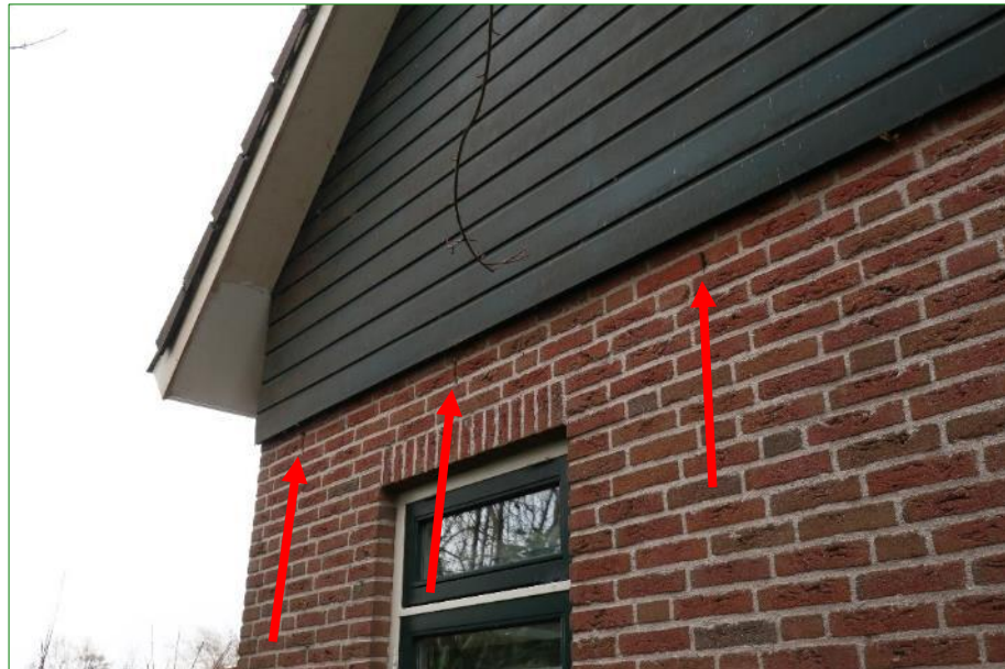
De openingen in de spouwmuur (rode pijlen) rondom de bedrijfswoning geven mogelijk toegang tot voor vleermuizen geschikte achterliggende ruimtes.
