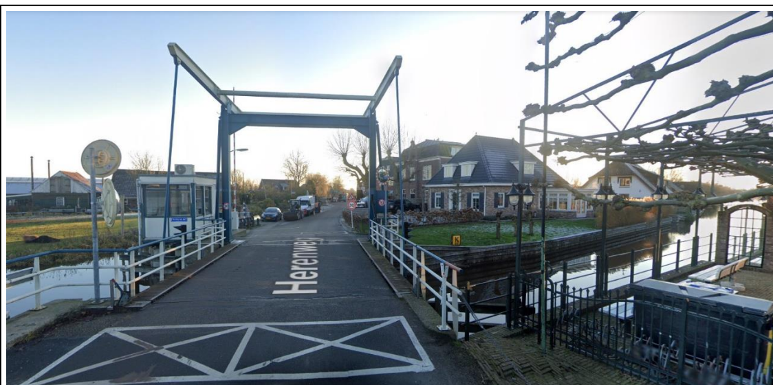
Figuur 10 – De Heulbrug gezien vanaf de Herenweg (vanuit het noorden), met aan de rechterzijde de Heulsloot (bron: Google Streetview)
