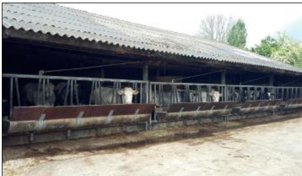
Een van de te slopen runderstallen
