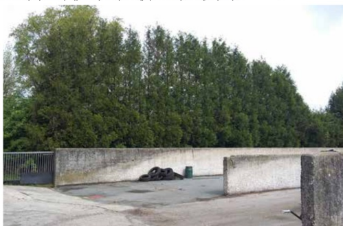
Sleufsilo's en coniferen als huidige erfbepanting.
