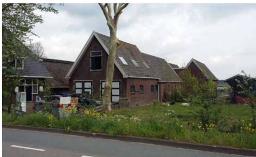
Zicht op het koetshuis vanaf de Rijksweg.
