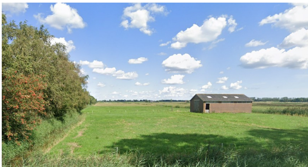
Figuur 7: Loods ten oosten van het recreatie terrein.
