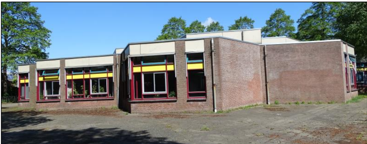
Figuur 1.3 Overzichtsfoto van de zuidwestzijde van het schoolgebouw (Foto: Eco Reest BV).
