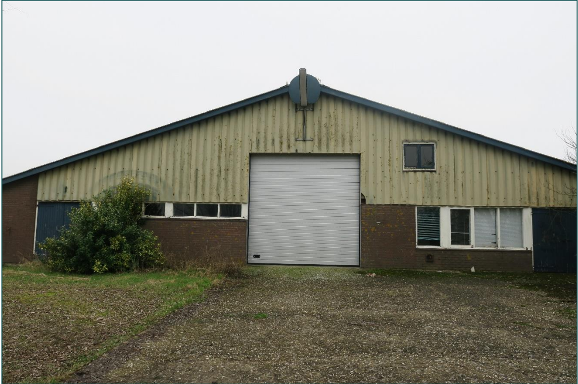
Figuur 1.2 De voormalige veestal zal gesloopt worden t.b.v. de realisatie van een vrijstaande woning.
