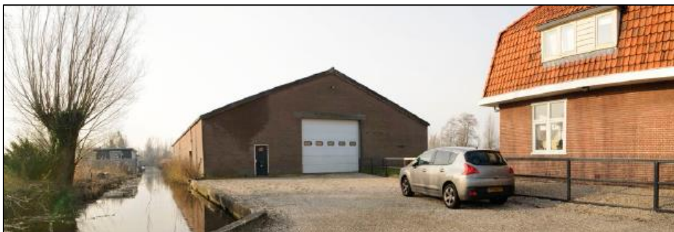
Te slopen bestaande bedrijfsloods
