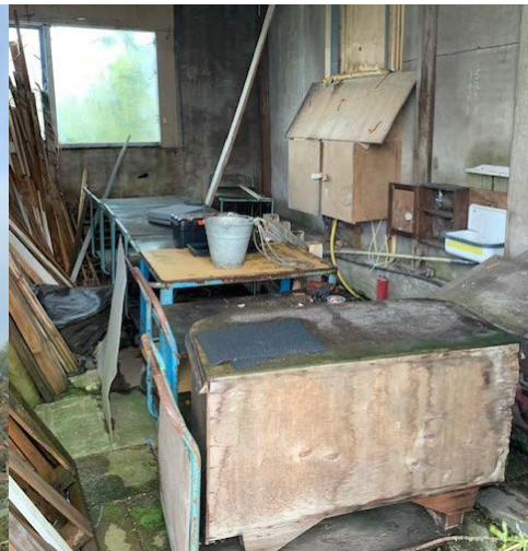
Loods inpandig, noordoostelijk deel
