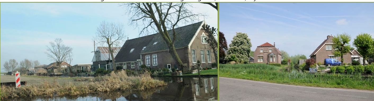
Grote monumentale boerenerven aan de oostzijde. Tussengelegen kavels zijn inmiddels volgebouwd.
