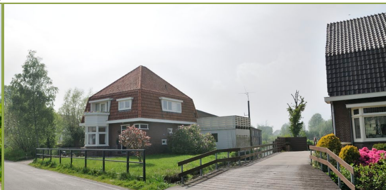
De aanbouw blokkeert het zicht op het achterland.
