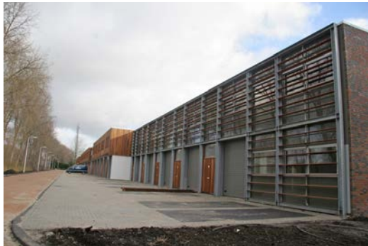
Eenduidige vormgeving en horizontaliteit van de gevel, onderscheid boven- en onderbouw.
