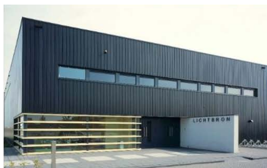
Fraai gevelmateriaal en goede gevelopbouw met entree en horizontale raampartijen.
