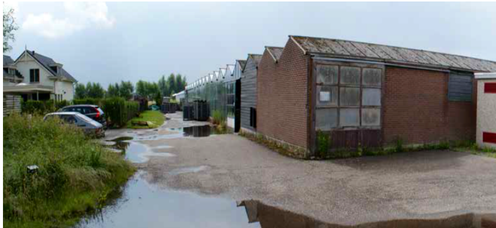
Afbeelding 7: woonhuis links is Demmerik 128; kwekerij rechts is Demmerik 128a
