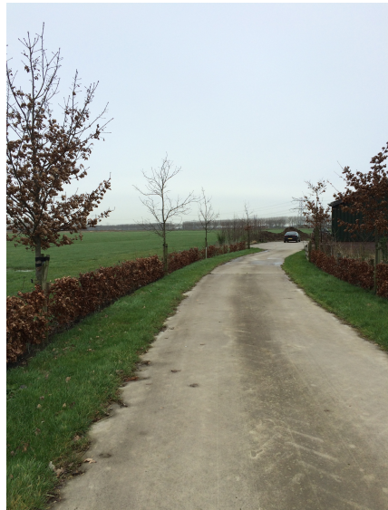
Afbeelding 4. De toegangsweg, zicht vanaf de Rijksstraatweg
