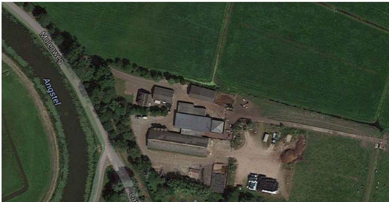
Figuur 1. Bestaande bedrijfsgebouwen Molenweg 22
