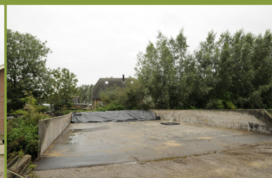
sleufsilo voeropslag te dicht op de erfgrans
