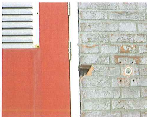
Foto 10: Spouwen: geen asbest aangetroffen
