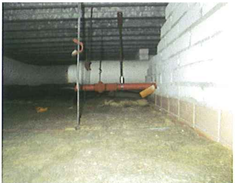
Foto 8: Luchtbehandelingskanalen (Abm/001): geen asbest
