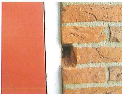
Foto 9: Spouwen: geen asbest aangetroffen
