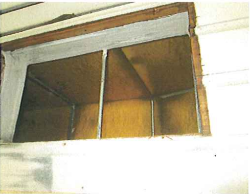
Foto 5: Luchtbehandelingskanalen (Abm/001): geen asbest
