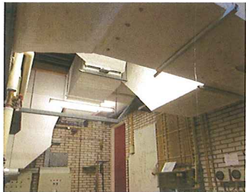
Foto 4: Luchtbehandelingskanalen (Abm/001): geen asbest
