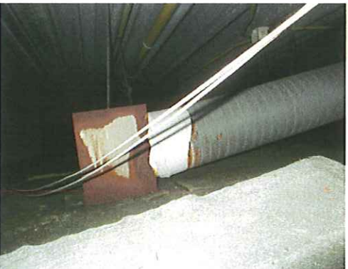
Foto 7: Luchtbehandelingskanalen (Abm/001): geen asbest
