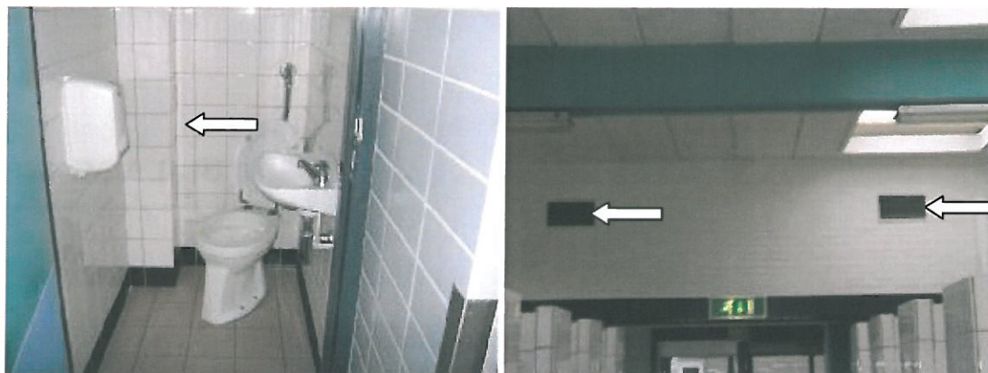
Foto 1 en 2: Achter vaste wand,- vloer en plafonddelen zitten mogelijk luchtkanalen / plaatmateriaal / riolering.
