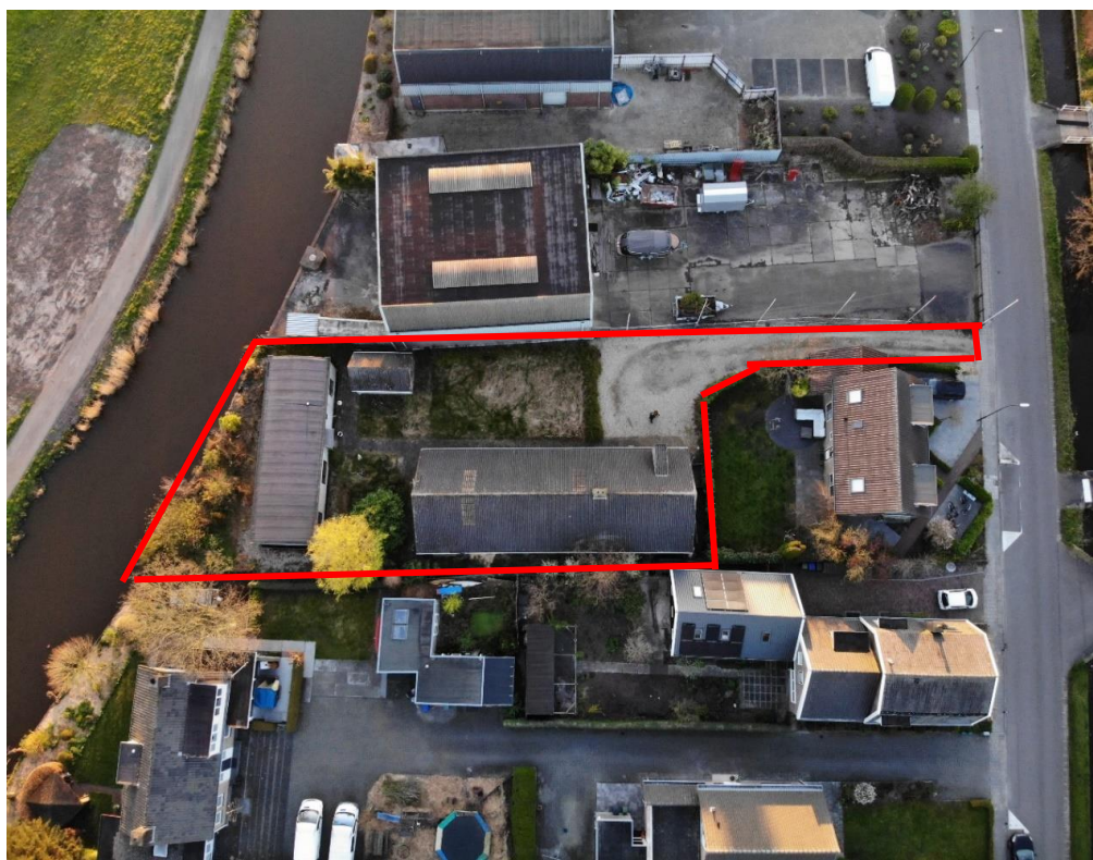
Figuur 3 perceel met bestaande opstallen, begrenzing met rode markering aangegeven
