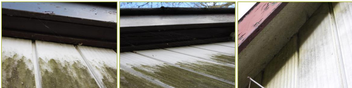
Afbeelding 6. Geen openingen lang de dakrand bij de woonboot (links en midden) en ook niet bij het kleine schuurtje (rechts).
