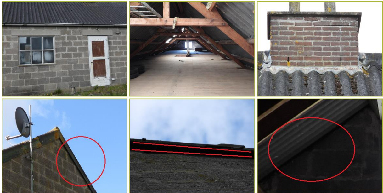
Afbeelding 7. Grote schuur opgetrokken uit betonblokken dus geen spouw (linksboven), lichte zolder zonder vleermuissporen en wegkruipmogelijkheden (midden boven). Voor vleermuizen te smalle stootvoegen in de schoorsteen (rechts boven). Voor vleermuizen toegankelijke spleet (linksonder) maar als te breed, licht en tochtig beoordeeld (midden onder) en bovendien loopt deze direct door in de zolder en is dus geen echte wegkruipmogelijkheid (rechts).
