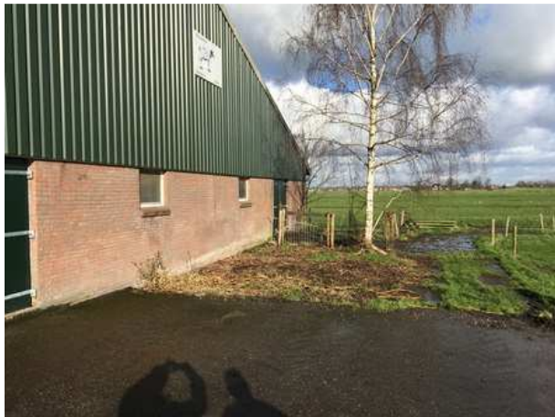
Buitengevel van de stal waar tegenaan de nieuwe melkstal gebouwd zal worden. Vleermuizen bezetten geen verblijfplaats in de gevel van de ligboxenstal.
