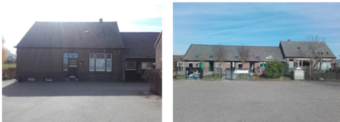
Figuur 9 foto's aanzicht woning en kinderdagverblijf van de noordoost- en zuidwestzijde
