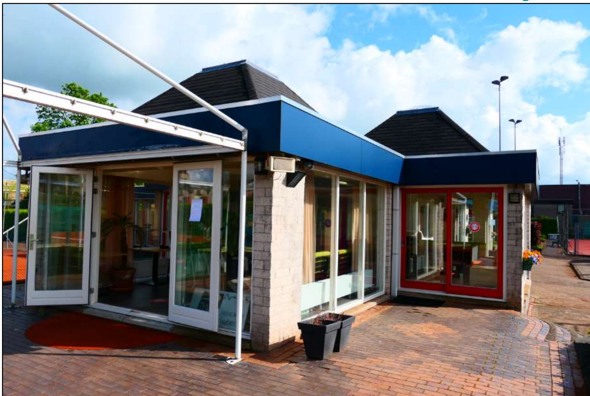
Afbeelding 2.3 Kantine / verenigingsgebouw TVM, gezien vanuit westelijke richting.
