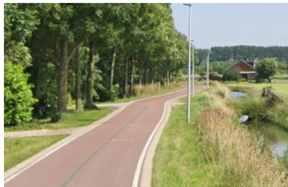
referentie fietsstraat met kruidenrijke berm, Houten
